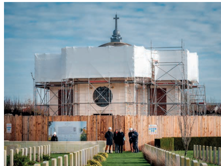
La grande chapelle du Saint-Sever Cemetery Extension, à Rouen, en France, sous échafaudage pendant le vaste projet de restauration entrepris cette année.
